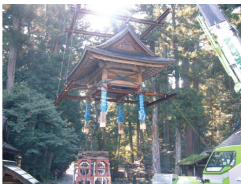
レッカー車による手水舎の移転 (10月31日)
