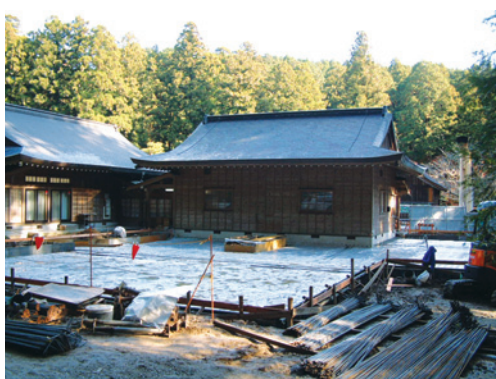
社務所増改築工事 (基礎部分・12月14日)
