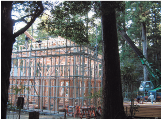
上棟の現況 (北側)
