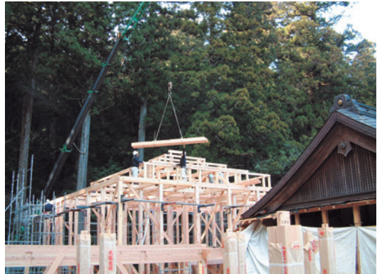
社務所増改築工事の上棟 (3月2日)
