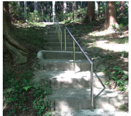
大宝殿への階段に手すりの設置(4月17日)
