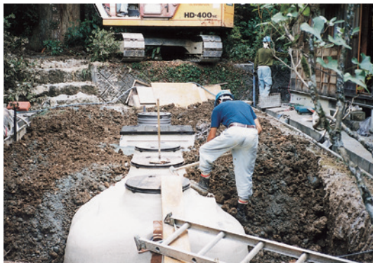
合併浄化槽の埋設
