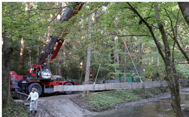
宮川堰堤付近で行われた石橋移設工事(10月18日)
