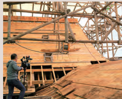
▲神徳殿・渡り殿 古い屋根を剥がし調査をおこなう（令和2年3月13日）
