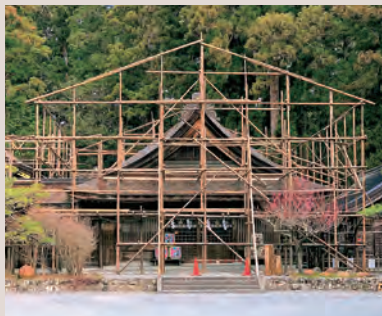
▲神徳殿 社叢にも馴染む木製の足場（令和2年2月18日）
