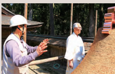
▲真名井の完工 屋根を確認する宮司
