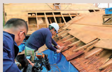
▲渡り殿の軒付け作業と調査風景
