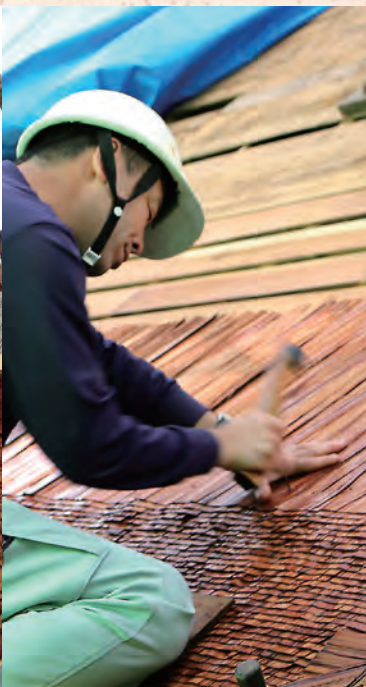
檜皮を竹釘にて打ち込む様子▲
