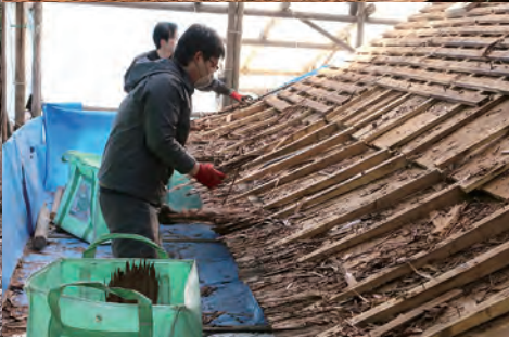
▶檜皮の解体作業
