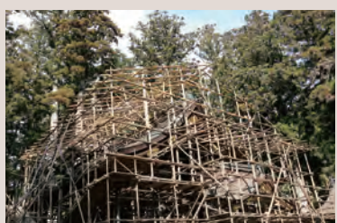
▲ご本殿 木製の足場
