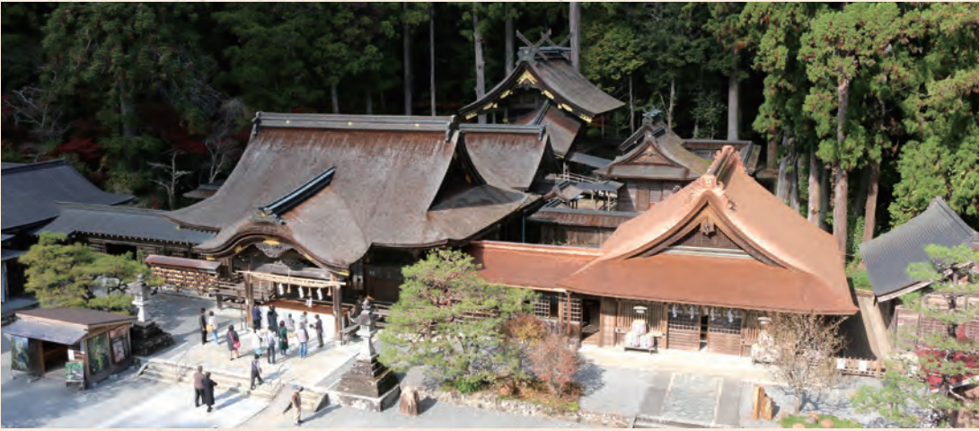
お屋根替え工事を行う社殿▲
