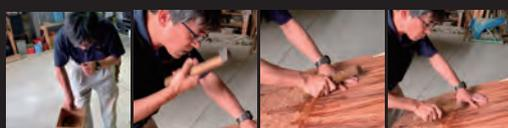
20~30 本程の竹釘を口に含み、舌を使って一本ずつ口から釘を出します。金槌を握る手で釘を掴み、屋根金槌の「伏金」と呼ばれる部分で檜皮に差込み、金槌で打ち込みます。金槌の格子状の溝により竹釘の頭が潰れ、抜けない形状で完全に打ち込まれます。
